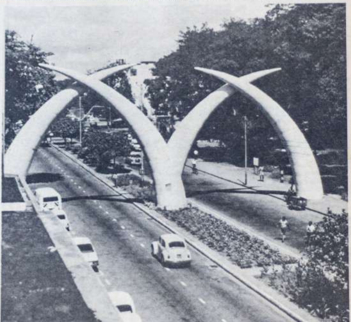
• DIE ELEFANTENZÄHNE, das moderne Wahrzeichen Mombasas, 1890 war die Straße nur etwa 4 Fuß breit und führte durch dichtes Dschungelgebiet. FOTOS: JOHN H. A. BOWELL
