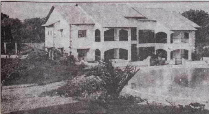
Die Ferienwohnungen im Woburn Residence Club, Malindi, bieten einen Panoramablick über die wunderschöne Anlage und die Swimmingpools.
