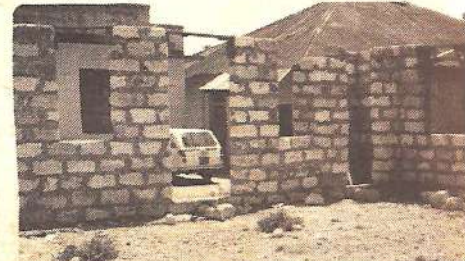
• UJENZI WA Madrassatul Abraar, Makadara, Mombasa.
