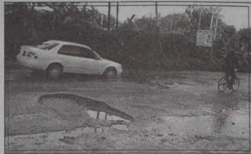
VORHER: Eine der schlimmsten Straßenstrecken befindet sich in Nyalil bei der Abzweigung zur Links Road, wo sich jeweils lange Autoschlängen bilden, wenn die Leute zur Arbeit in die Stadt fahren. Trotz ständiger Reparaturen sind die Löcher nach dem Regen jeweils noch größer als vorher, weil die Entwässerung fehlt.
