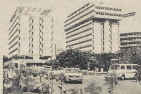
AMBALAL HOUSE, eines der modernsten und höchsten Gebäude in Mombasa.
